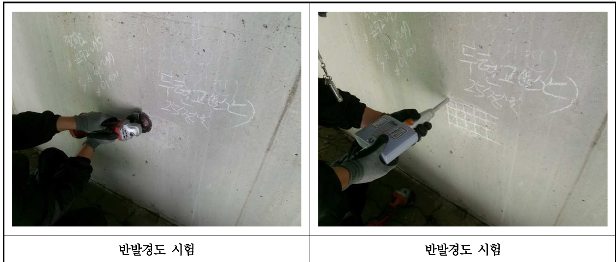
【사진 18.4.2】 반발경도시험 현장사진
