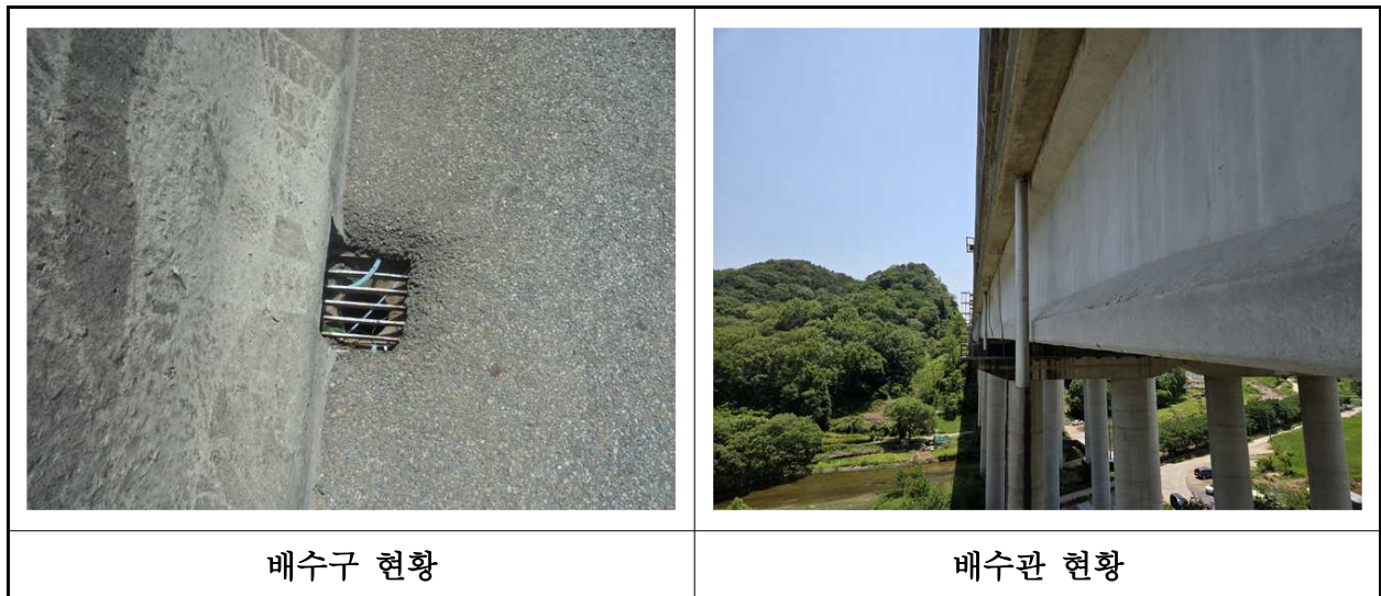
【사진 18.3.22】 배수시설 전경
