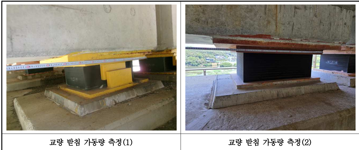
【사진 18.3.16】 교량받침 이동량 측정
