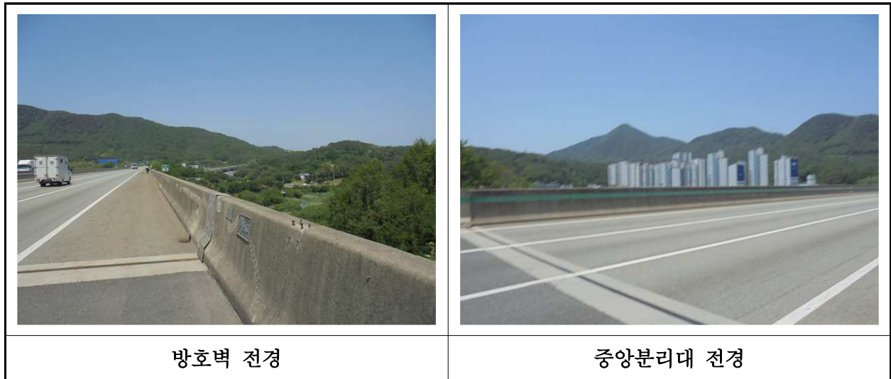
【사진 18.3.24】 방호벽 및 중분대 전경
