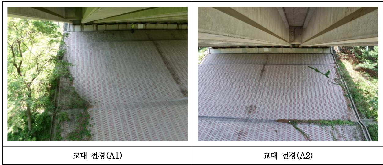
【사진 18.3.8】 교대 전경
