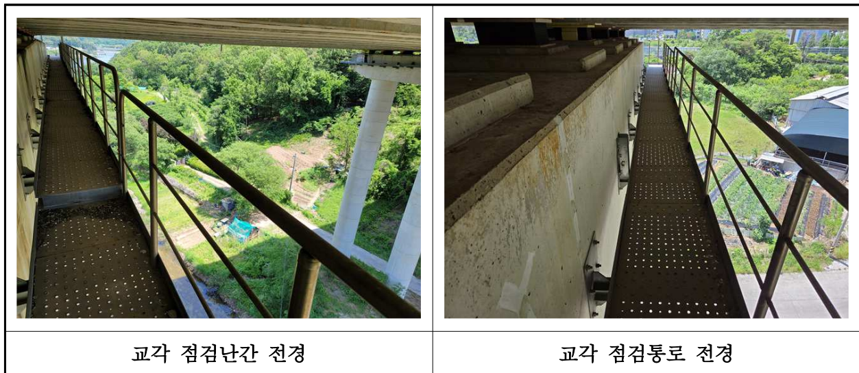
【사진 18.3.26】 교량 점검시설 전경
