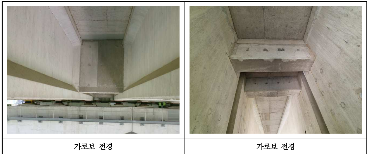
【사진 18.3.6】 가로보 전경
