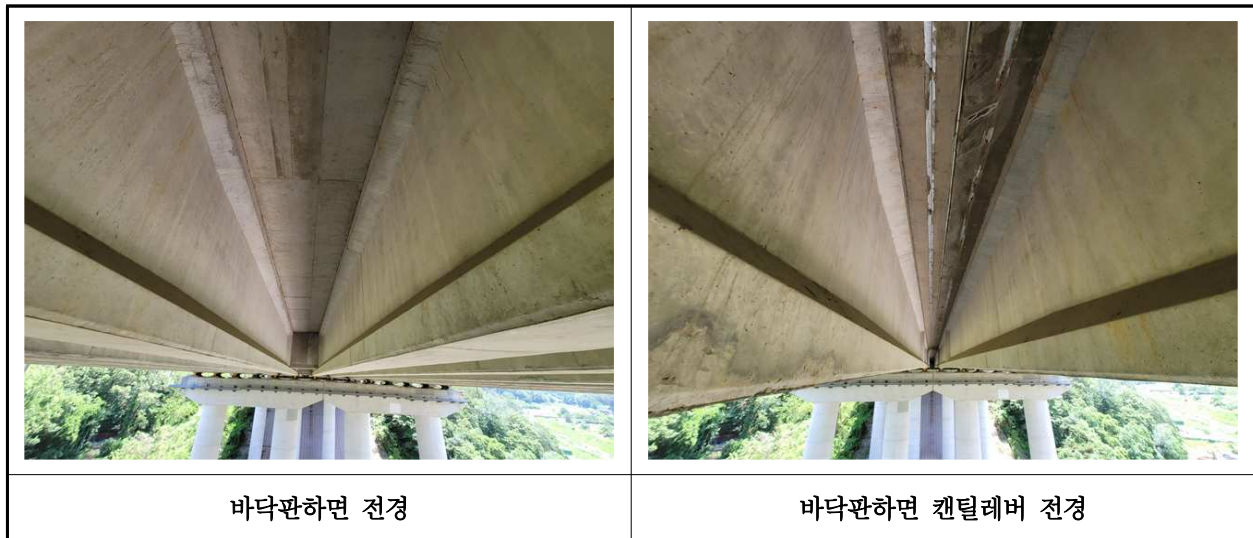
【사진 18.3.2】 바닥판하면 전경
