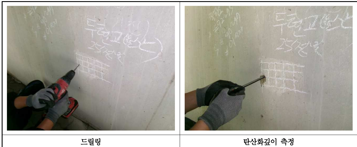
【사진 18.4.3】 탄산화 깊이 측정 현장사진
