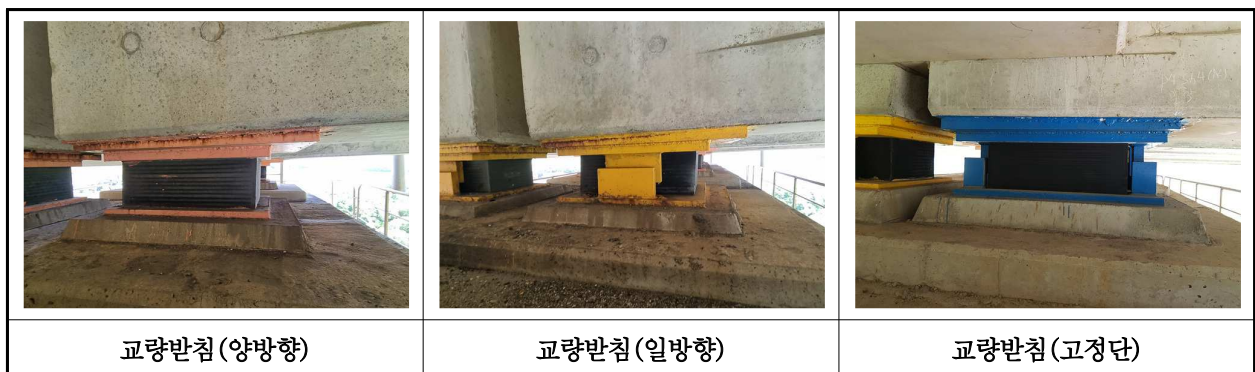
【사진 18.3.13】 교량받침 전경
