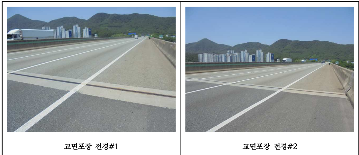
【사진 18.3.20】 교면포장 전경
